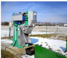
vertikální samočistící česle - SČČ, Troubsko
