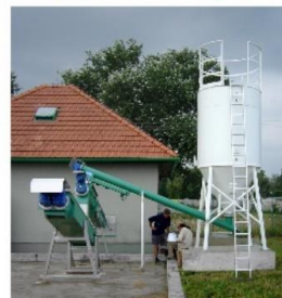
hygienizace kalu vápnem - HKV, ČOV Podlívka
